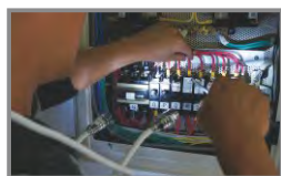
● 電箱修理照明
